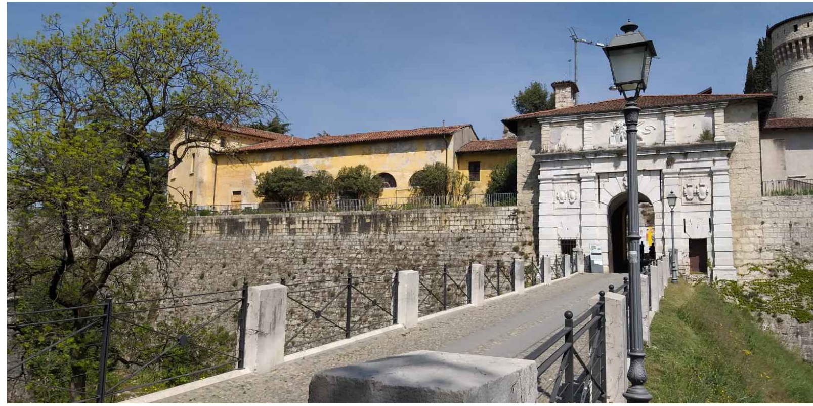
1_Fotografia dal ponte di ingresso al Castello
