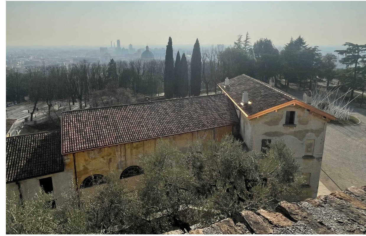
2_Fotografia coperture complesso Palazzina del Governatore e ex Chiesa S.Stefano nuovo
