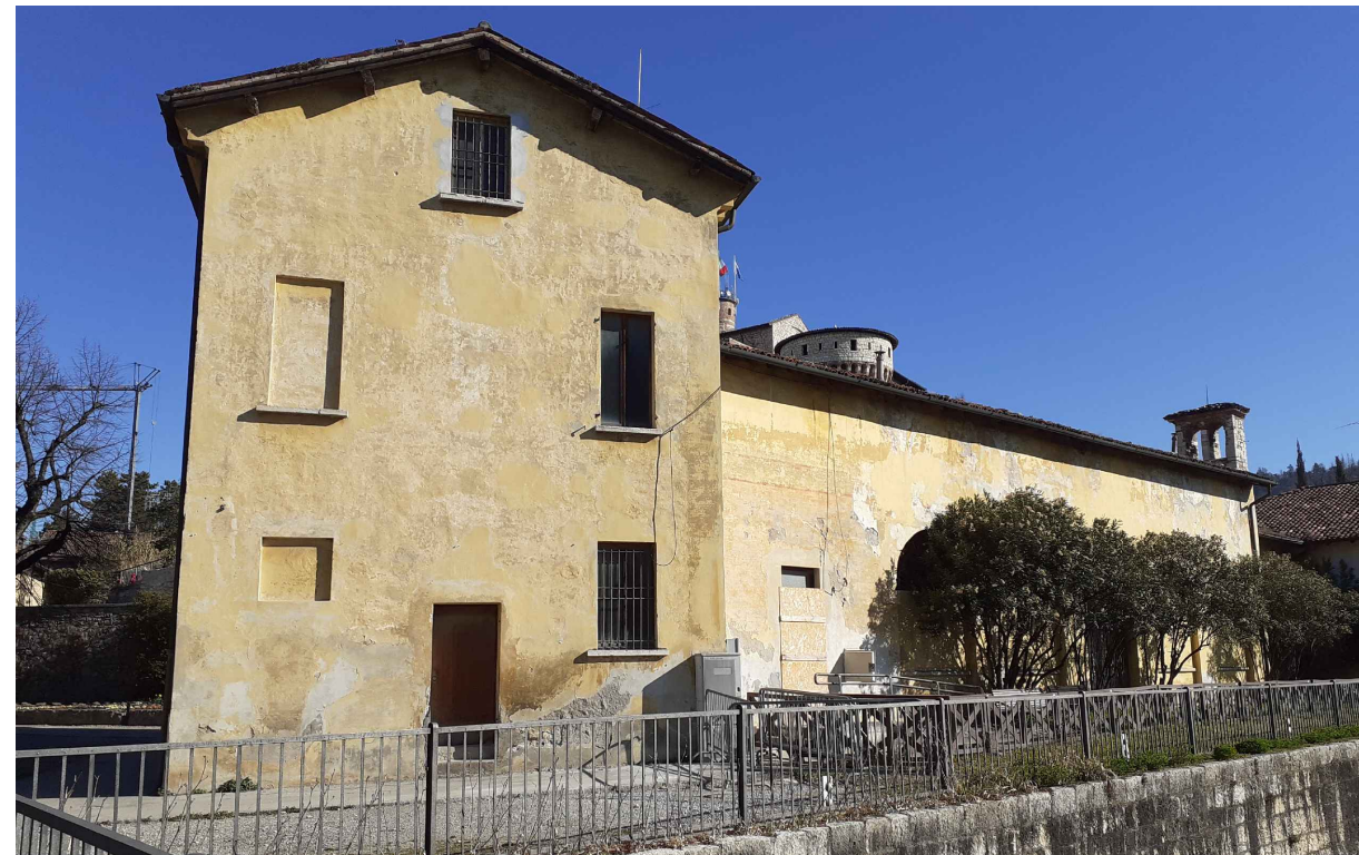
4_Fotografia fronte Sud Palazzina del Governatore e ex Chiesa S.Stefano nuovo prima degli ultimi interventi
